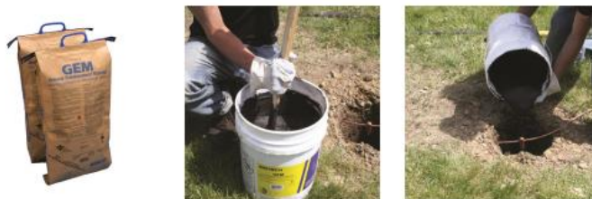
Slika 5: Način postavljanja GEM mase
